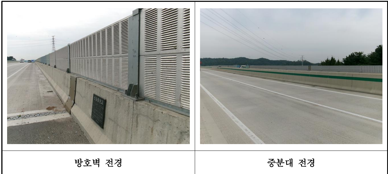
【사진 34.3.23】 방호벽 및 중앙분리대 전경
