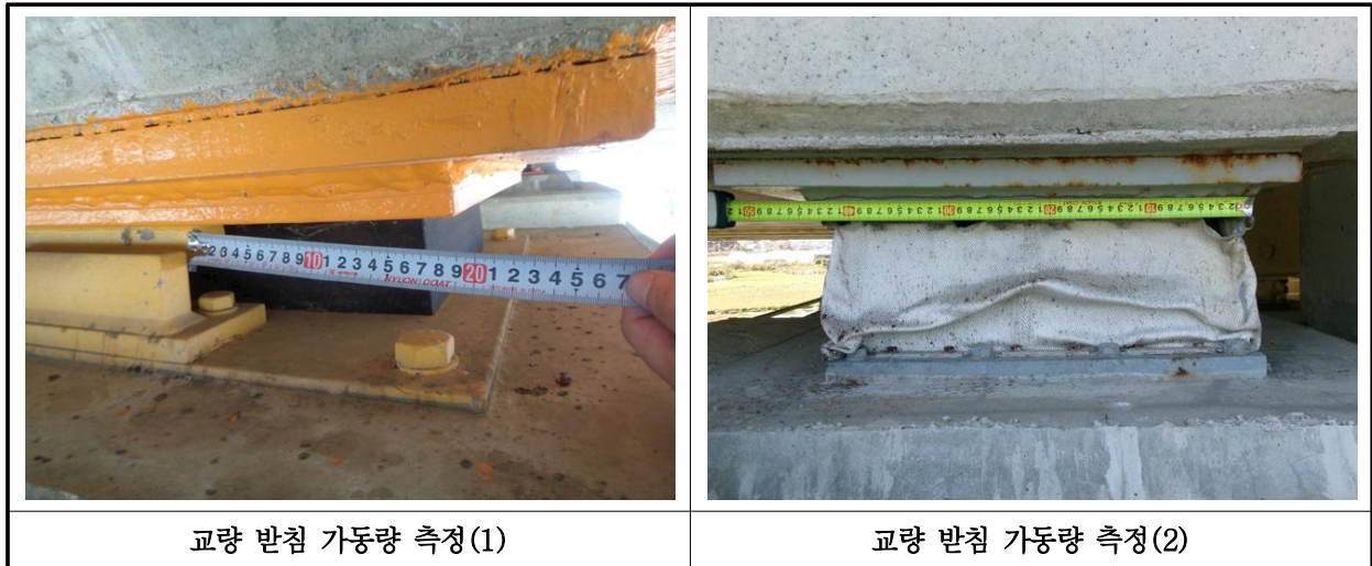
【사진 34.3.15】 교량받침 이동량 측정
