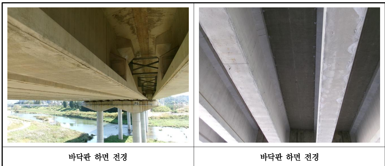
【사진 34.3.2】 바닥판하면 전경
