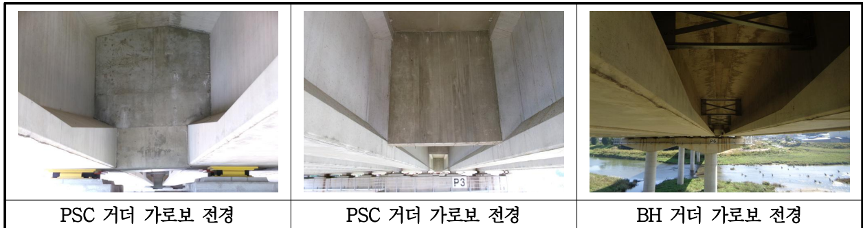
【사진 34.3.6】 가로보 전경
