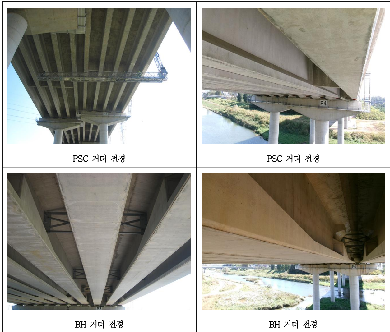
【사진 34.3.4】 거더 전경
