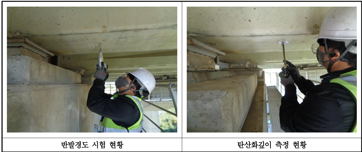
【사진 34.4.1】 콘크리트 내구성조사 현황
