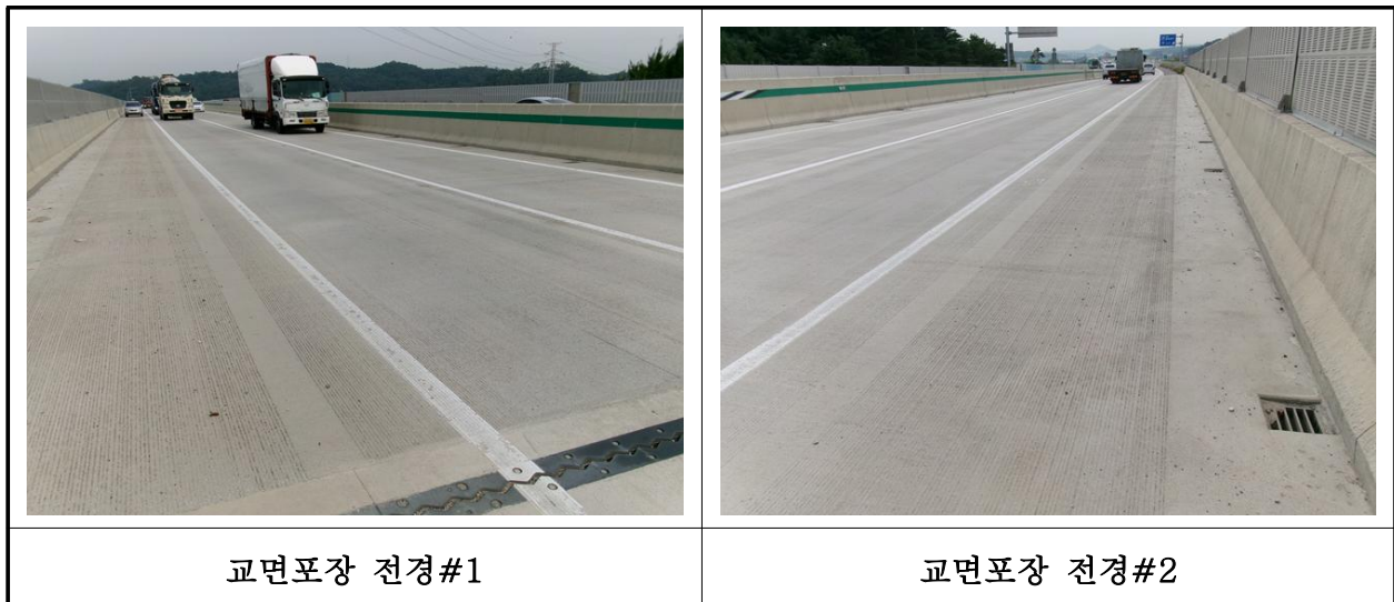
【사진 34.3.19】 교면포장 전경
