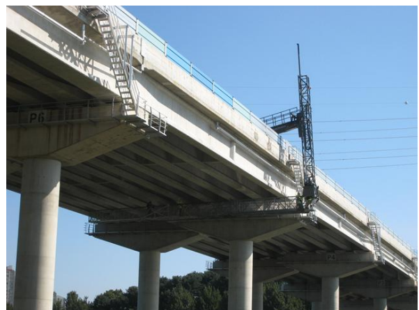
굴절차를 이용한 거더 근접조사
