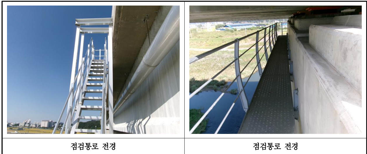
【사진 34.3.25】 교량 점검시설 전경
