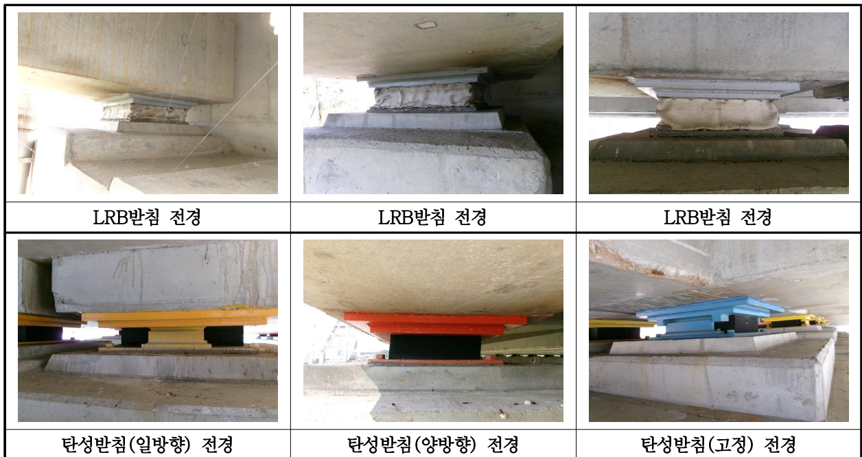
【사진 34.3.12】 교량반침 전경
